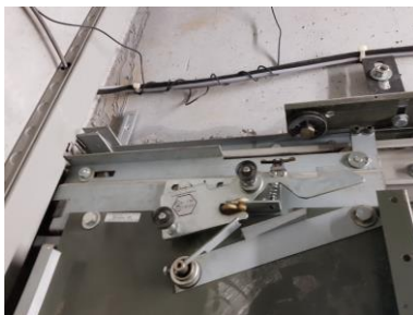
Serrure de porte palière du niveau principal
